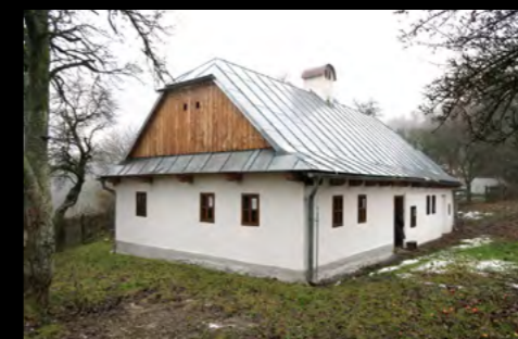
Miners House in Štiavnické Bane
