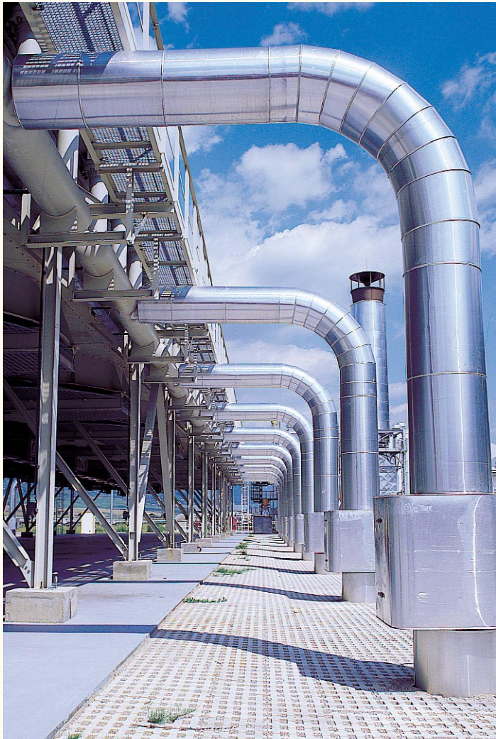
Chladienie plynu na kompresorovej stanici
