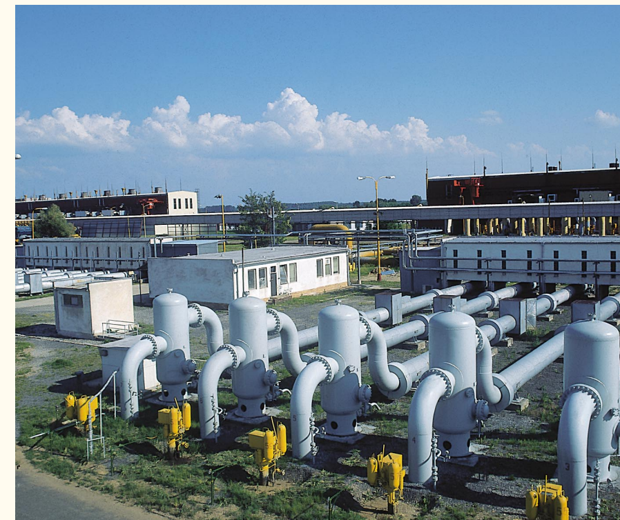
Filtračné jednotky na kompresorovej stanici
